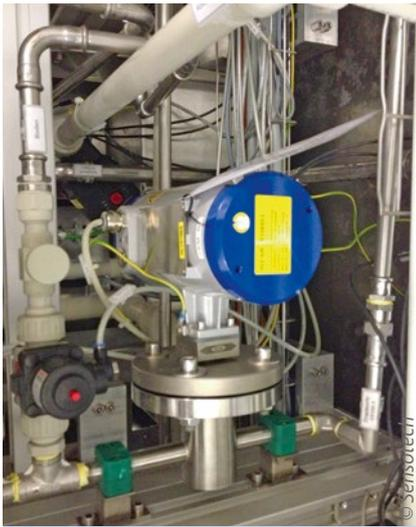
Bild 3: Der Tauchsensoren ist in einer Rohrleitung der Reinigungsanlage bei Robert Bosch installiert und misst kontinuierlich die Reinigerkonzentration
